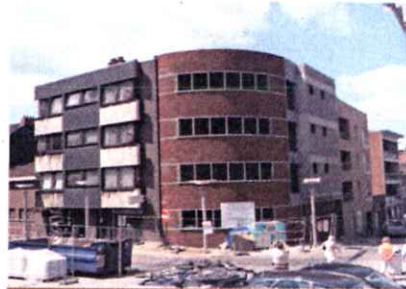
TUBIZE, rue des Poissonniers 4 logements moyens Installation de l'électricité, du chauffage et des sanitaires.
