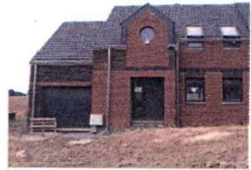
TUBIZE, rue de la Moisson 10 logements à vendre Rejointoyage et placement du chauffage.
