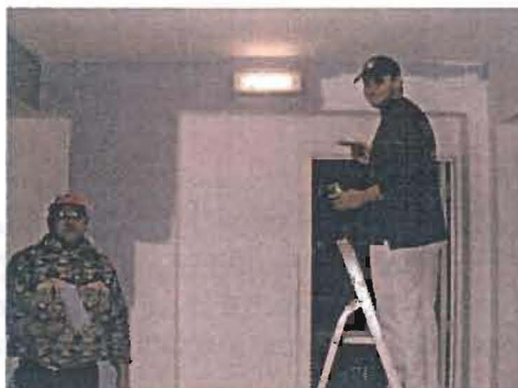
Finition de la nouvelle entrée du bloc 53.
