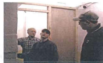
Réalisation d'un local pour le Guichet social.
