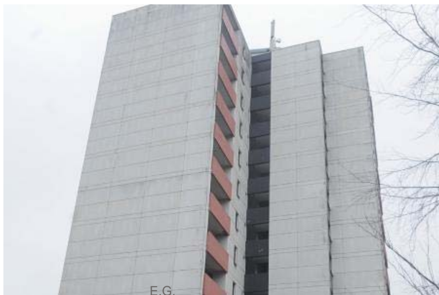
M. Deduytsche avait fait une chute de 4 étages dans cet immeuble.
